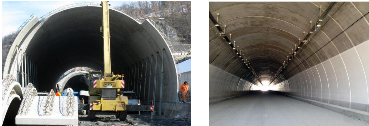
Figura 8 Esempio di rivestimento eseguito utilizzando predalles curve
